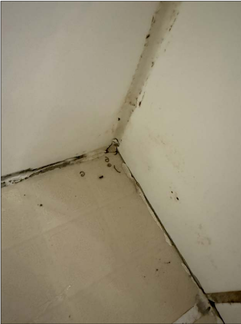
Fortsatt lyst til å dusje? Her er det mark i dusjområdet etter manglende renholds-rutiner. Anlegget er to år gammelt.
