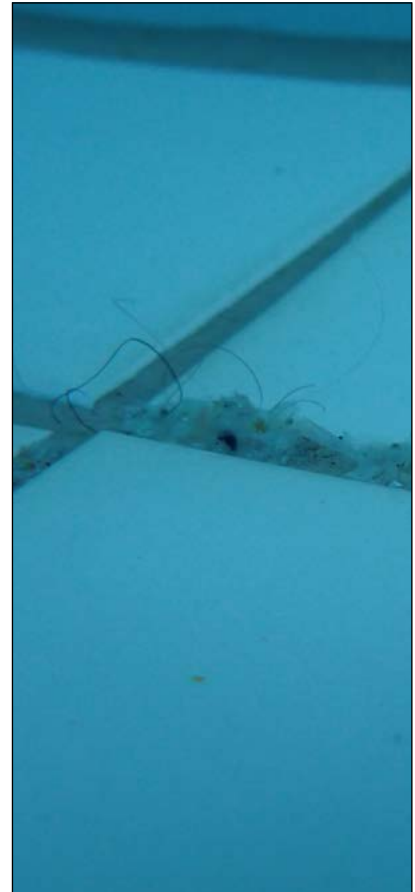
Vekst i fugene Dette 25-metersbassen-get er ikke tømt og rengjort på to år.
