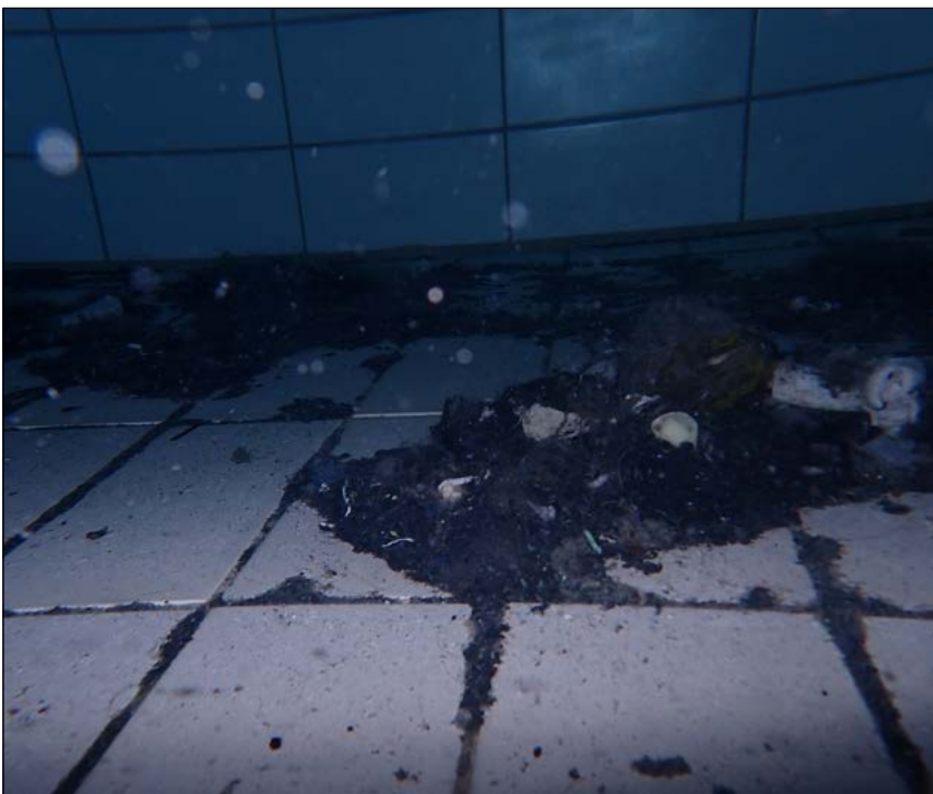
Ute av syne, ute av sinn... Skitt under hev- og senkbar bunn i et basseng som ikke er tømt og rengjort på 15 år.
