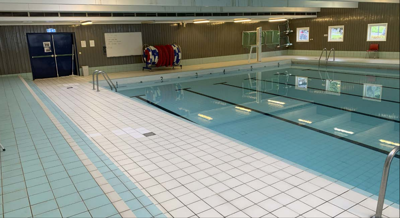
Figur 1 Klassiske svømmebassenger fra perioden 1960 - 1990 ble bygget i betong.
